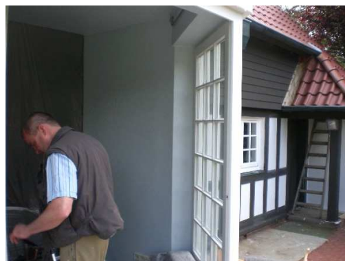
Demontage der alten Fenster
